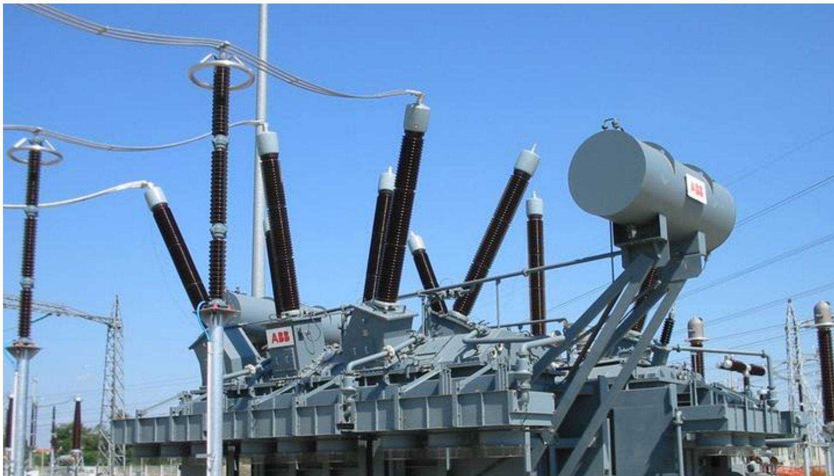
Transformador de cambio de fase - "Cambio de fase"
