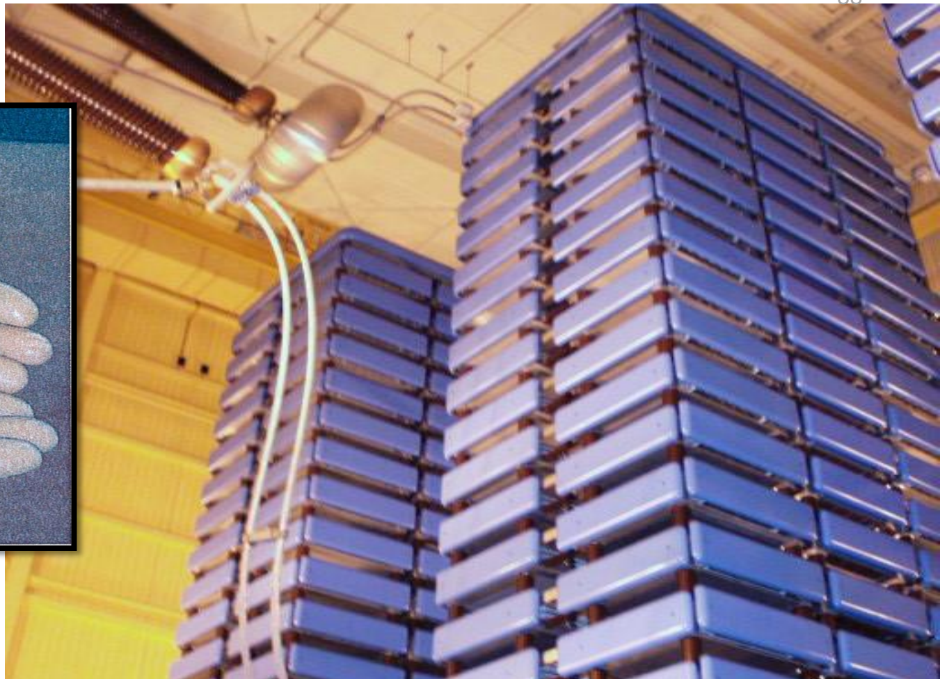
Pila de válvulas de tiristor
