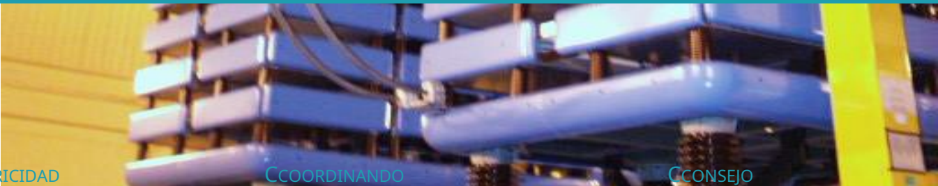
Pila de válvulas de tiristor
