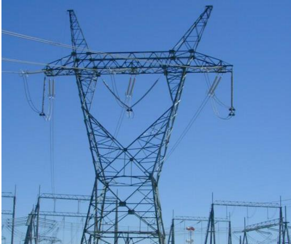
Torre de celosía de acero de 500 kV
